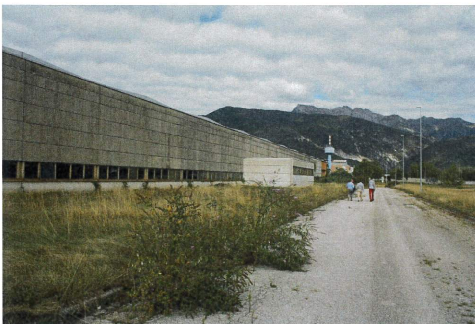
Immagine del capannone industriale a Maniago
