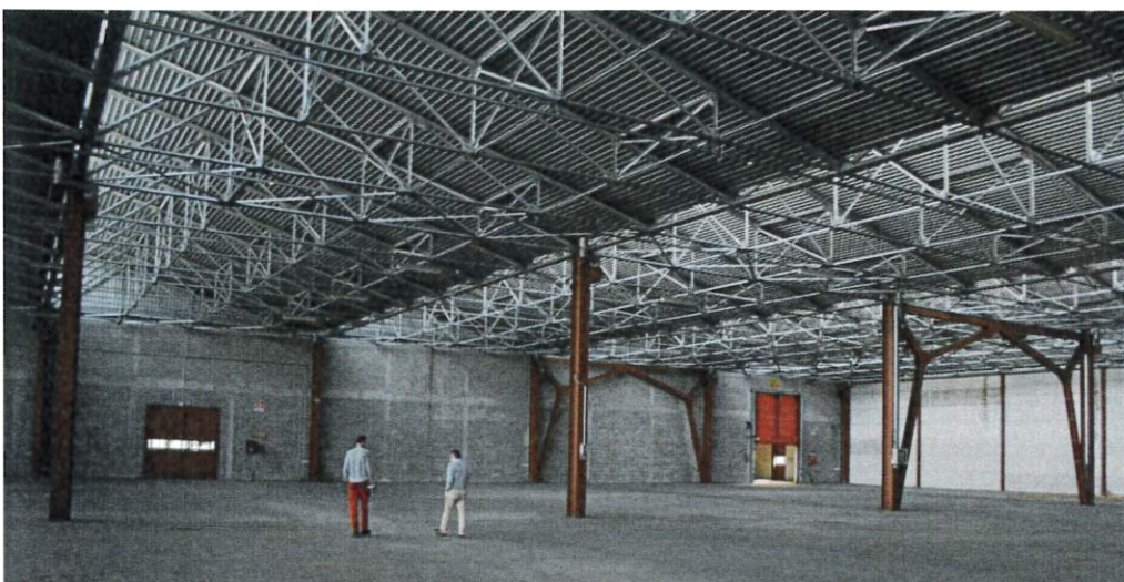
Immagine dell'interno capannone industriale
