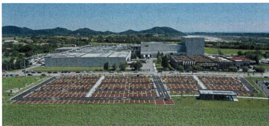
Immagine di un parcheggio realizzato dal NIP di Maniago
