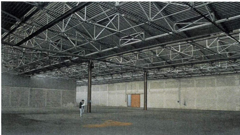
Immagine dell'interno capannone industriale
